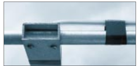
Bild 2: Befestigung der Elemente und der Phasenleitungen
